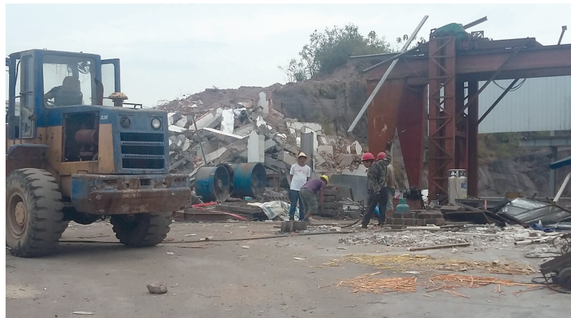
超乾公司拆除企业厂房违建
