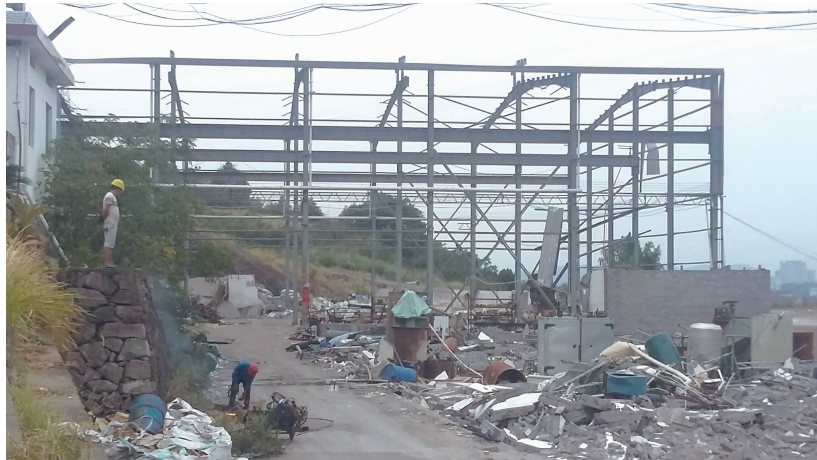
超乾公司拆除青龙头违建厂房
