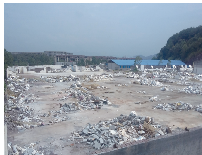
拆除汤岭脚村佛堂前地块违建
